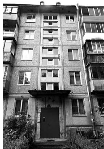
Ул. Заречная, д. 17. Замена оконных блоков.
