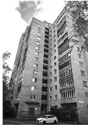
Ул. Заречная, д. 3. Замена трубопровода ГВС.
