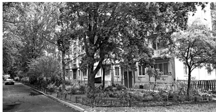
Ул. Заречная, д. 13. Замена трубопроводов ГВС и ХВС.
