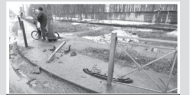
Повреждённое ограждение напротив выезда с ул. Ларина
