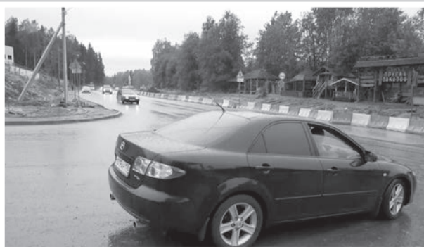
НА СНИМКАХ: перекрёсток Выборгского шоссе и дороги в микрорайон Новое Сертолово
