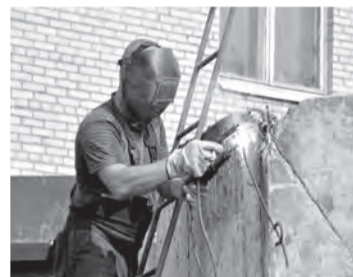
Идут подготовительные работы
