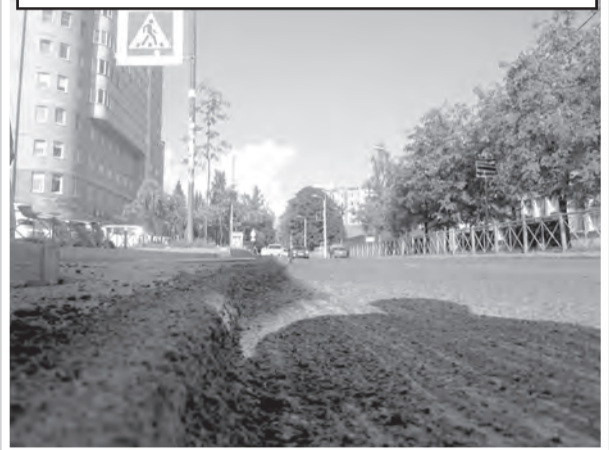
Снят верхний слой асфальта на ул. Ларина
