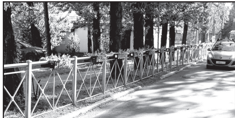
Установлено новое ограждение на ул. Ларина
