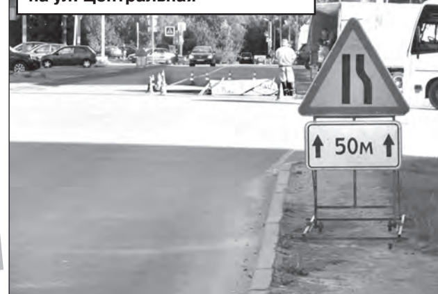
Нанесение дорожной разметки на ул. Центральная
