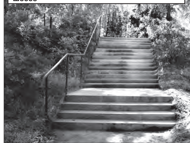
Отремонтированные ступеньки лестницы на аллее от Дома офицеров вдоль Выборгского шоссе
