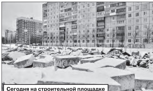
Сегодня на строительной площадке
