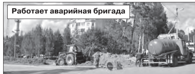
Замена аварийного участка трубы
